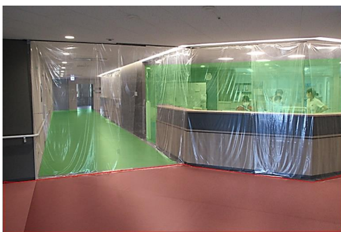
図 9：ビニールシートで清潔区域を拡大
