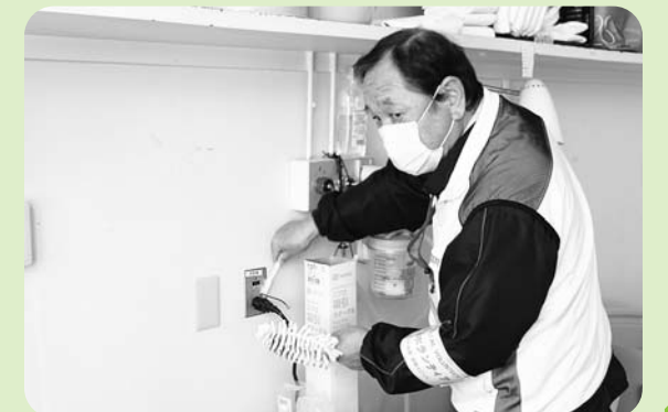
ボランティアさんによるコンセント点検・清掃
