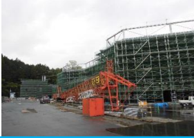
100tクレーンの解体
