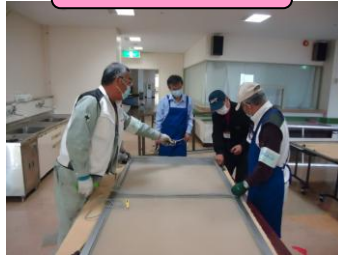
網戸補修の様子
