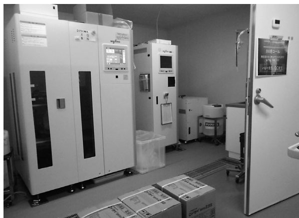
図2 新棟移転後の血液透センター資機材室
